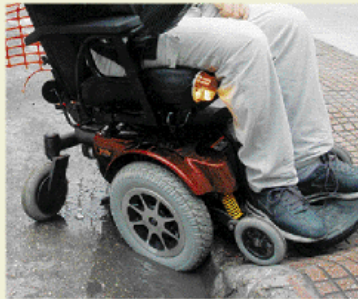
■ Αγαθουπόλεως και Πατησίων. Ράμπα που θυμίζει... σκαλί με αποτέλεσμα οι ρόδες να βρίσκουν στο πεζοδρόμιο, και ο κ. Αστέρης κινδυνεύει να πέσει
